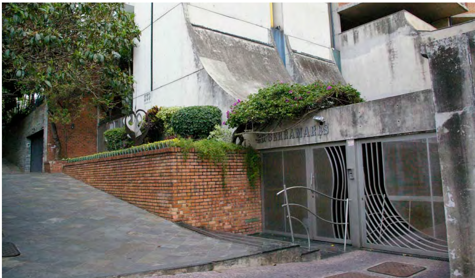
Intervenções do fechamento frontal ( gradil, guarda-corpo ) feita por terceiros
