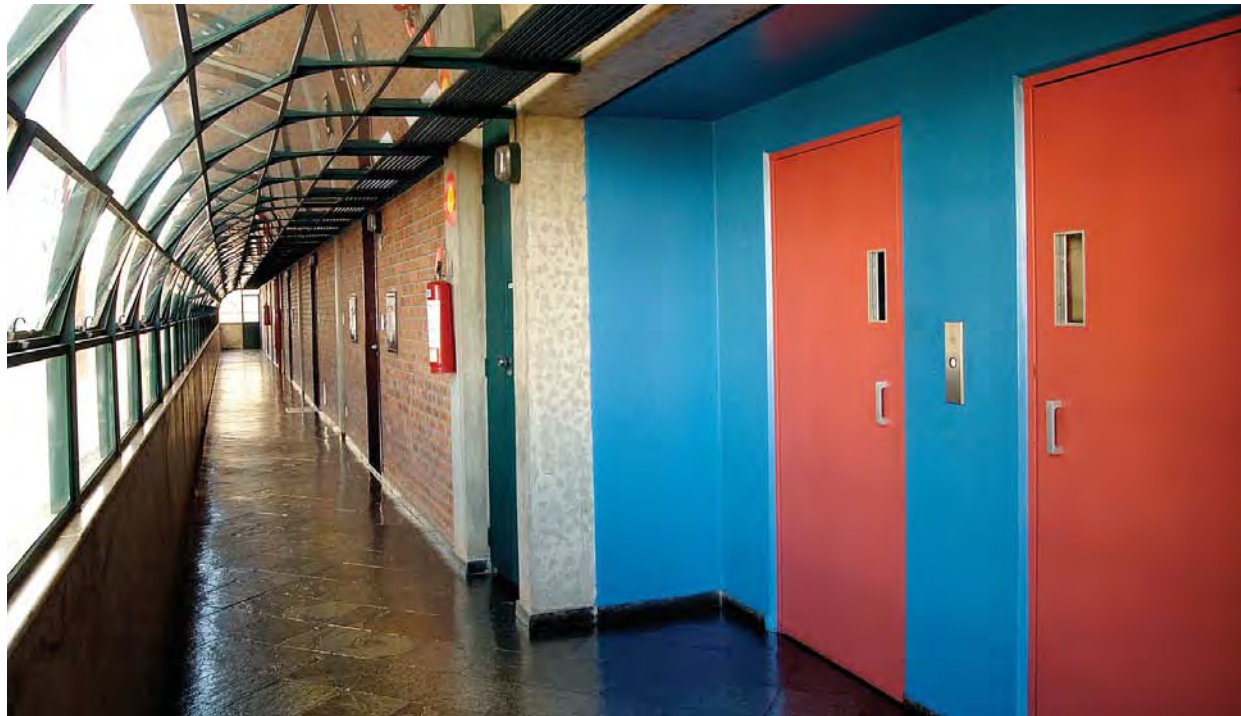
Vista circulação lateral (pavimento tipo)
