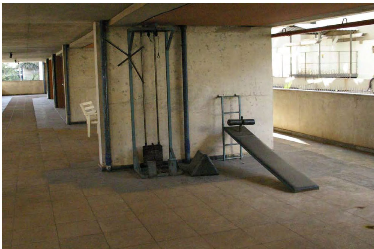
Intervenções no piloti, no corredor de adares tipo e na cobertura, setor comercial
